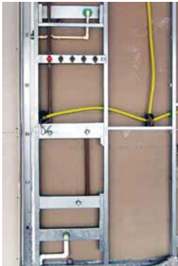
Figura 28 – Estrutura drywall com instalações
