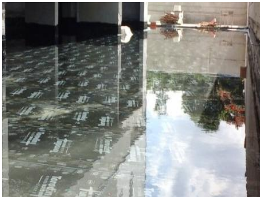
Figura 19 - Teste de estanqueidade.
