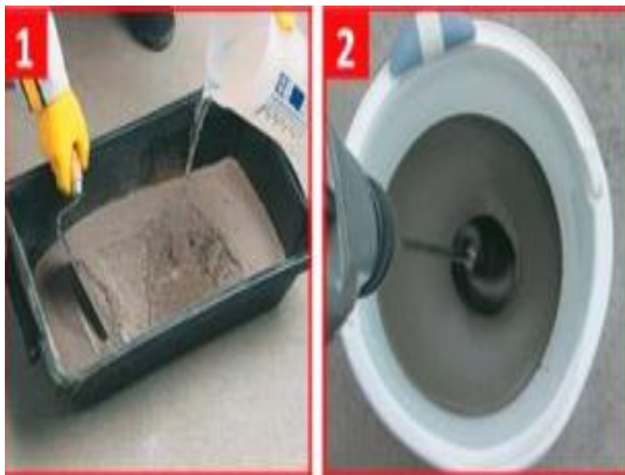
Figura 20 - Mistura de componentes da impermeabilização polimérica.
