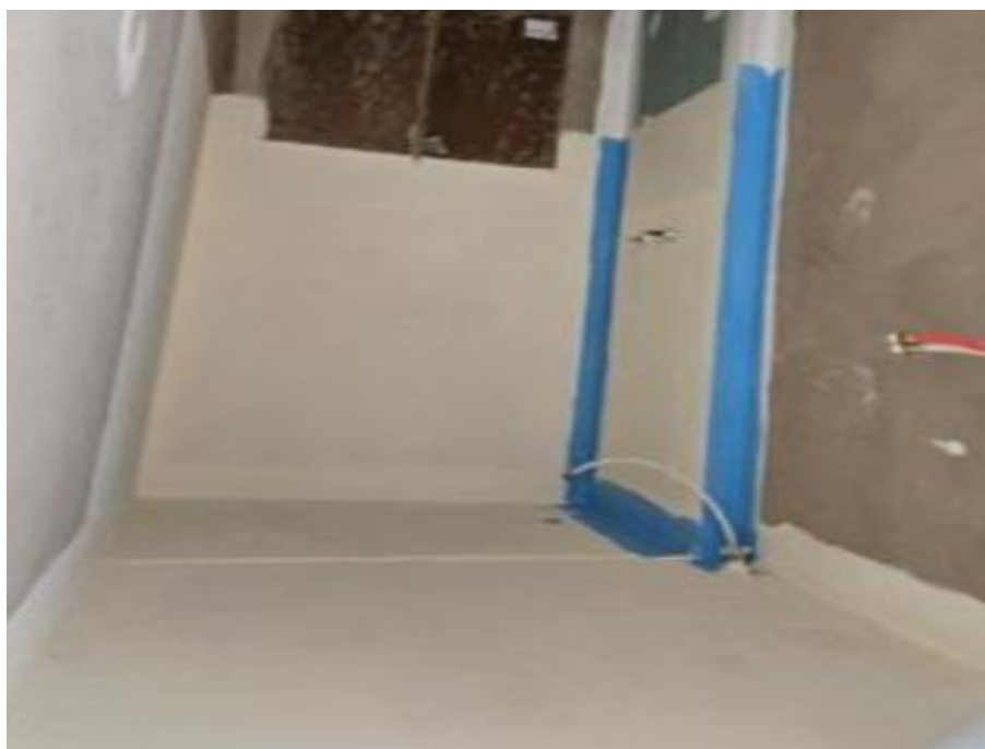
Figura 10 - Impermeabilização acrílica em banheiro.
