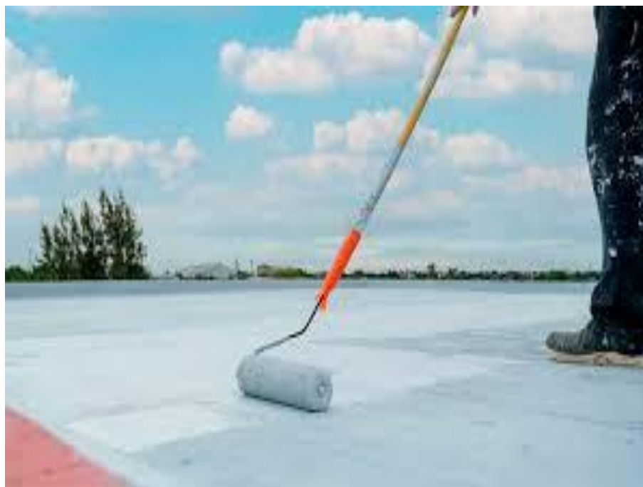
Figura 24 - Impermeabilização em laje.
