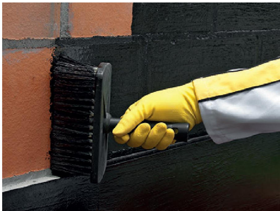
Figura 23 - Aplicação de impermeabilização em alvenaria.
