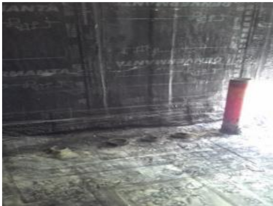
Figura 16 - Manta asfáltica no barrilete.
